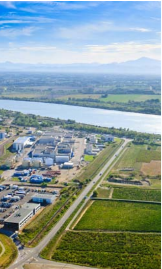
Photo aérienne de l'installation CENTRACO.
