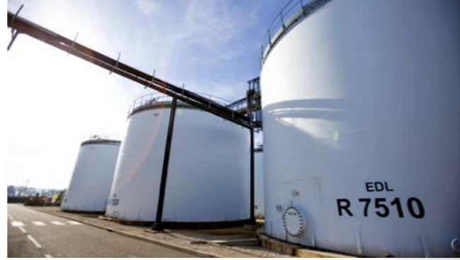
Cuves d'entreposage des EDL.
