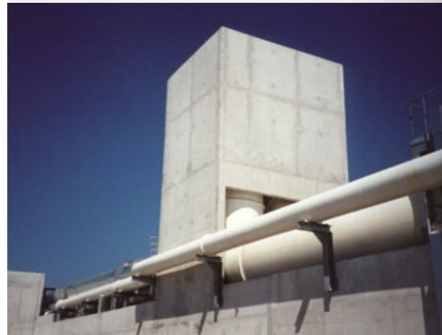
Cheminée de l'installation CENTRACO.
