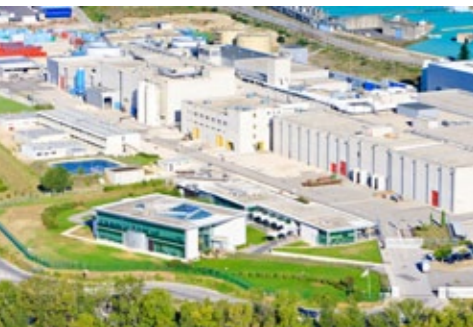
Photo aérienne de l'installation CENTRACO.
